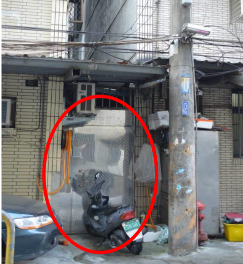
防火巷被搭建圍成私人倉庫
